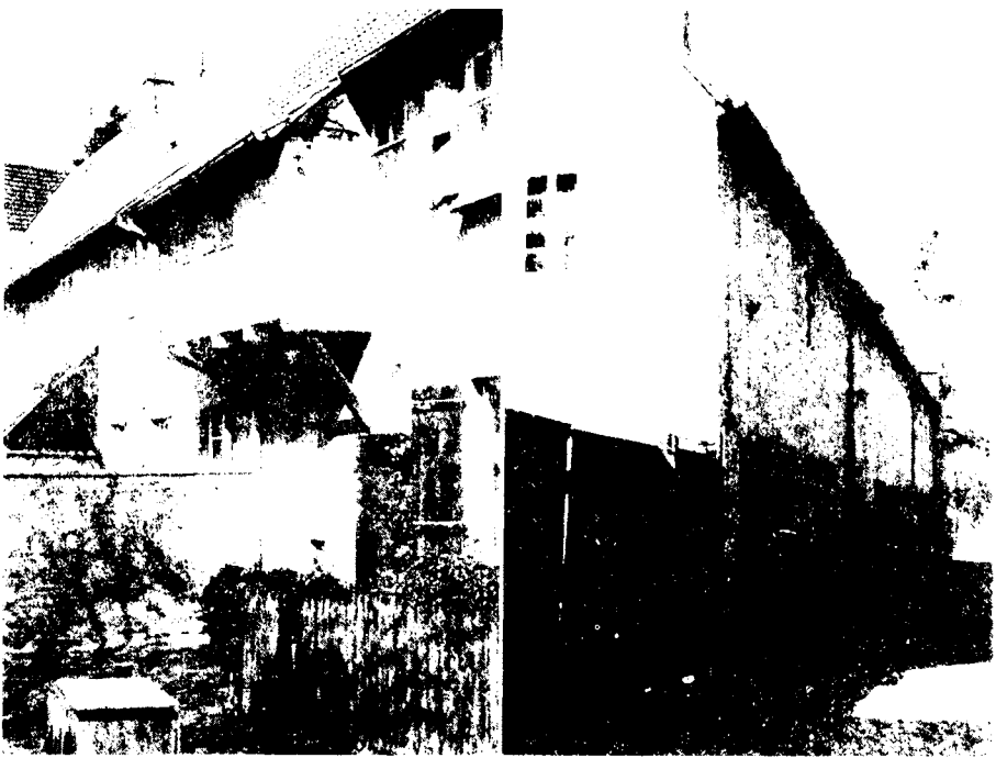
Das „Gelbe Haus“ in Wörlitz – wurden hier die Wörlitzer Kippermünzen geschlagen? Der alte Bau – links die Hof-, rechts die Straßenansicht – liegt wenige Schritte vom Marktplatz entfernt.
